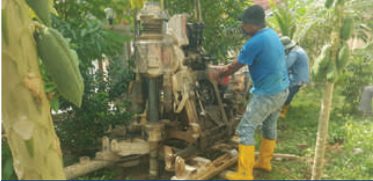
Kerja pelarasan peralatan ke posisi pengerudian
